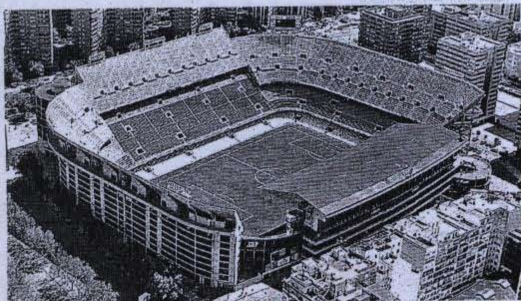
El estadio de Mestalla debe ser derribado... ¡pero no tan pronto!
